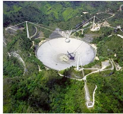
Arecibo Observatory (Puerto Rico) Σταθερό ραδιοτηλεσκόπιο διαμέτρου 305 m
