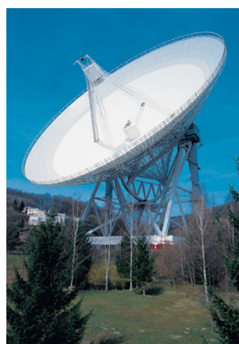
Effelsberg (Germany) Κινητό ραδιοτηλεσκόπιο διαμέτρου 100 m
