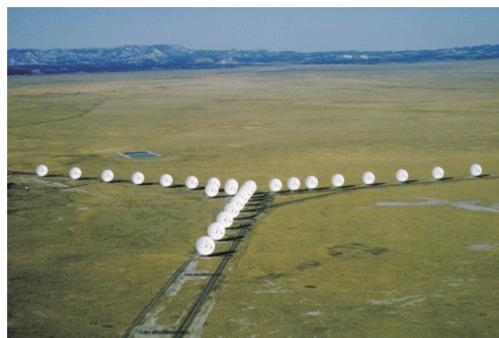
Very Large Array (VLA) - (New Mexico-U.S.A.) Συστοιχία 27 μετακινούμενων ραδιοτηλεσκοπίων διαμέτρου 25 m
